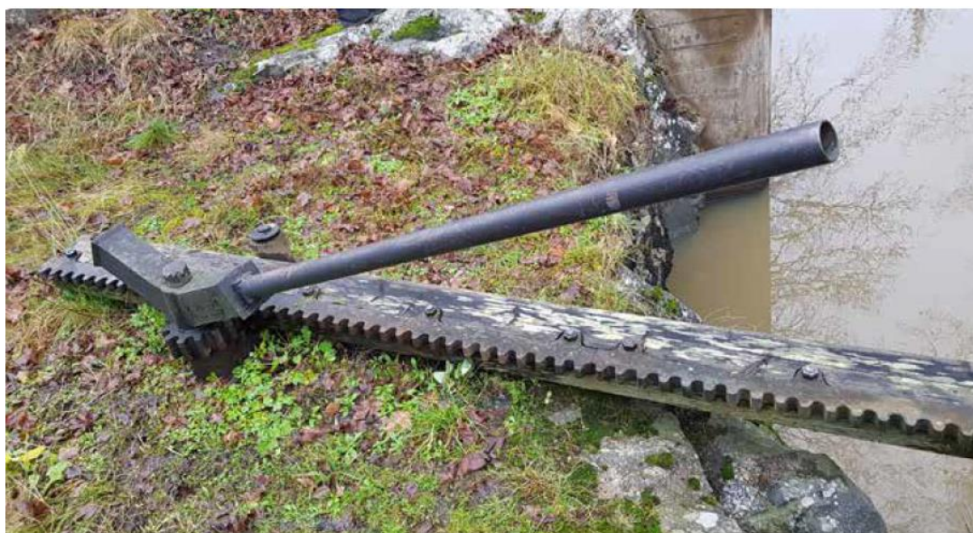
Figur 8. Visar hävvarmen som hjälper till att öppna slussportarna. ( Slussholmen Antikvarisk utredning och konsekvensanalys )
