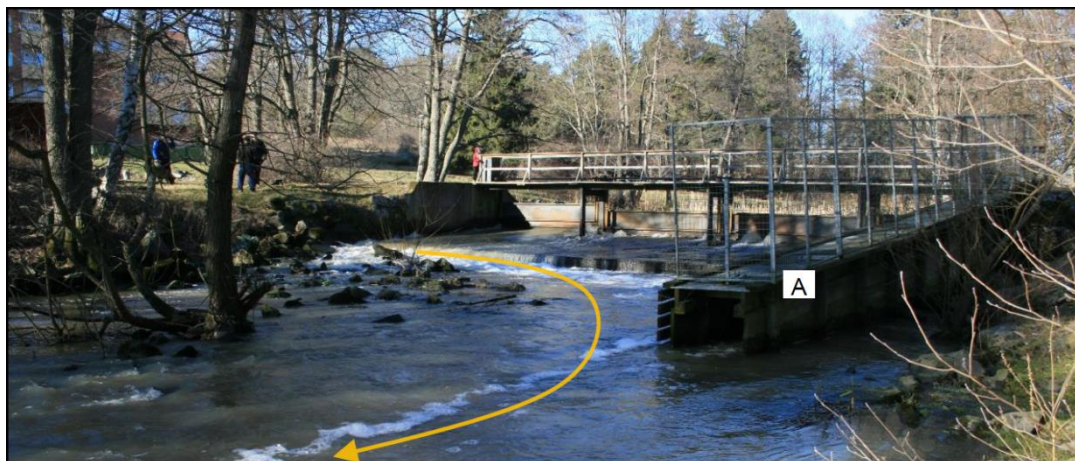
Figur 23. Befintligt dämme med nuvarande fiskväg (A). Fotografi upp mot dämmet från kanalens östra strand i riktning mot Slussholmen. Den dominerande strömfåran markerad med gul pil.
