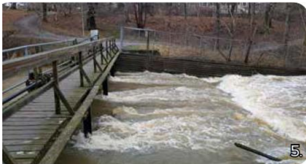
Figur 11. Regleringsdammen (Siffran 5 i Figur 5). ( Slussholmen Antikvarisk utredning och konsekvensanalys ).
