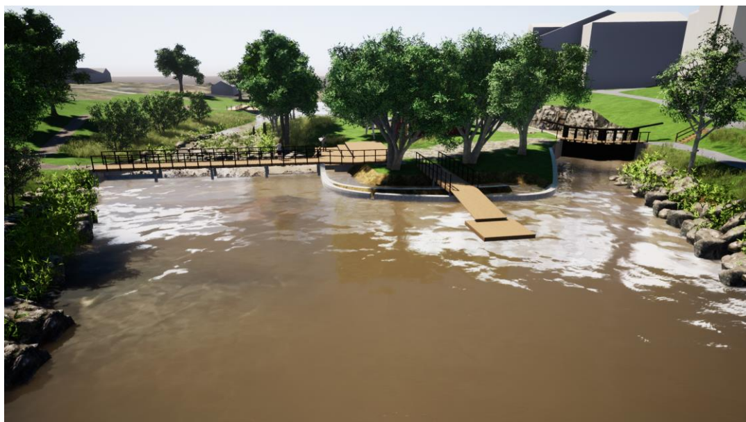
Figur 38. Visualisering av Slussholmens norra ände efter renoveringen av slussportarna och byte av brygga. Notera att fiskvandringvägen är flyttat med det övre inlöpet under den nya bryggan. Vidare kan den nya öppningsmekanismen ses på slussporten. (Österåkers kommun visualiseringsenheten)
