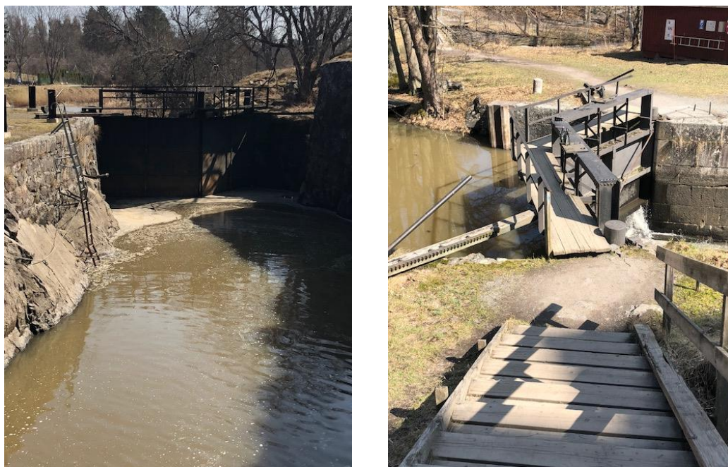
Figur 21. Till vänster den nedre slussporten och till höger den övre slussporten.
