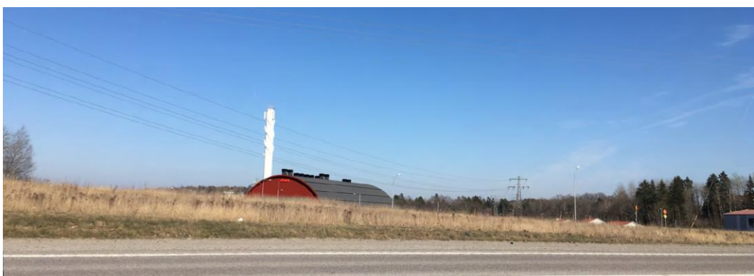
Figur 7. Befintligt värmeverk sett västerifrån, från väg 276.
