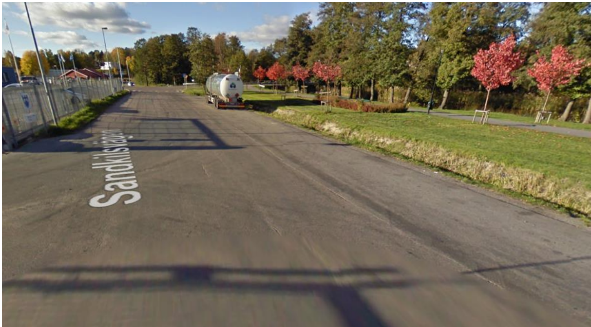
Figur 3. Befintligt dike norr om Sandkilsvägen.
