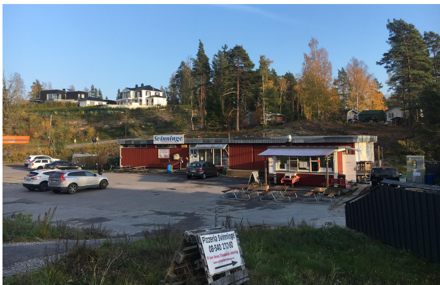
Svinninge handel sett från Svinningevägen.
