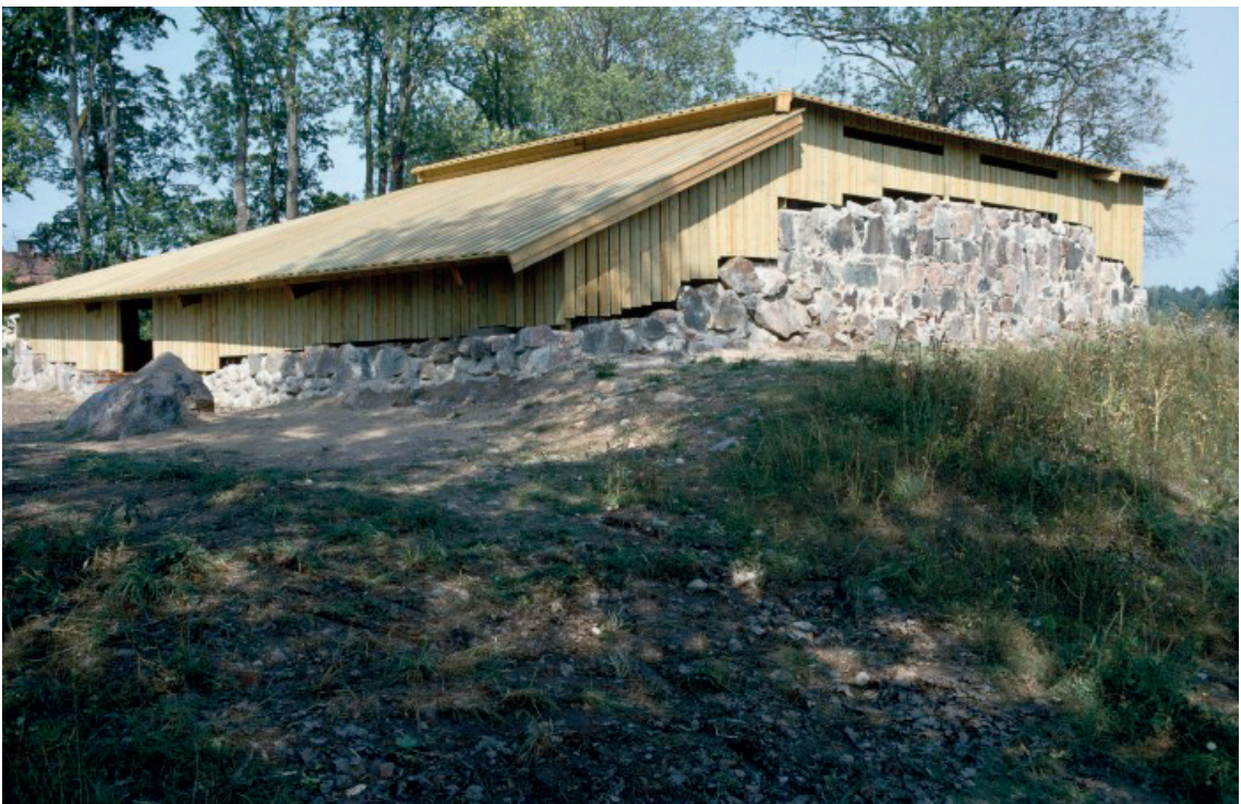
Figur 2. Det nyuppförda taket, från 1969. Foto: Alf Nordström, Stockholms läns museum CC BY-ND-NC
