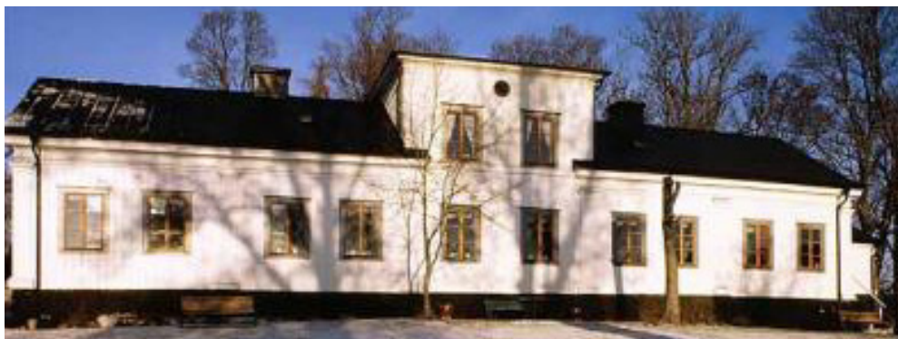
Herrgårdsbyggnaden på Smedby
