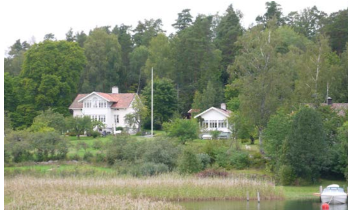
Nybygget, Svinninge 1:140, i planområdets nordöstra del, är en av de äldsta miljöerna i Svinninge. Nuvarande bebyggelse är i huvudsak från 1870-talet. Villan har frontespis och stor glasad veranda på den sida som vetter mot vattnet.
