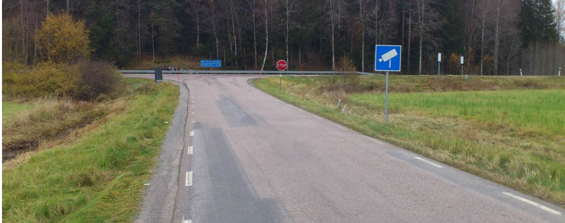
Figur: Vy från Skeppsdalsvägen norrut mot korsningen med väg 276
