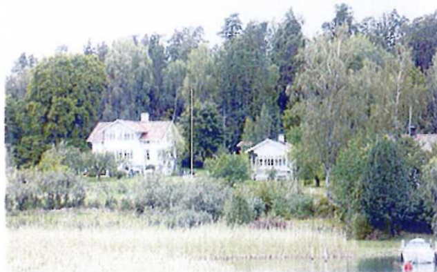
Nybygget, Svinninge 1:140, i planområdets nordöstra del, är en av de äldsta miljöerna i Svinninge. Nuvarande bebyggelse är i huvudsak från 1870-talet. Villan har frontespis och stor glasad veranda på den sida som vetter mot vattnet.
