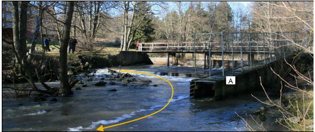
Figur 12. Befintligt dämme med nuvarande fiskväg (A). Fotografi upp mot dämnet från kanalens östra strand i riktning mot Slussholmen. Den dominerande strömfåran markerad med gul pil.
