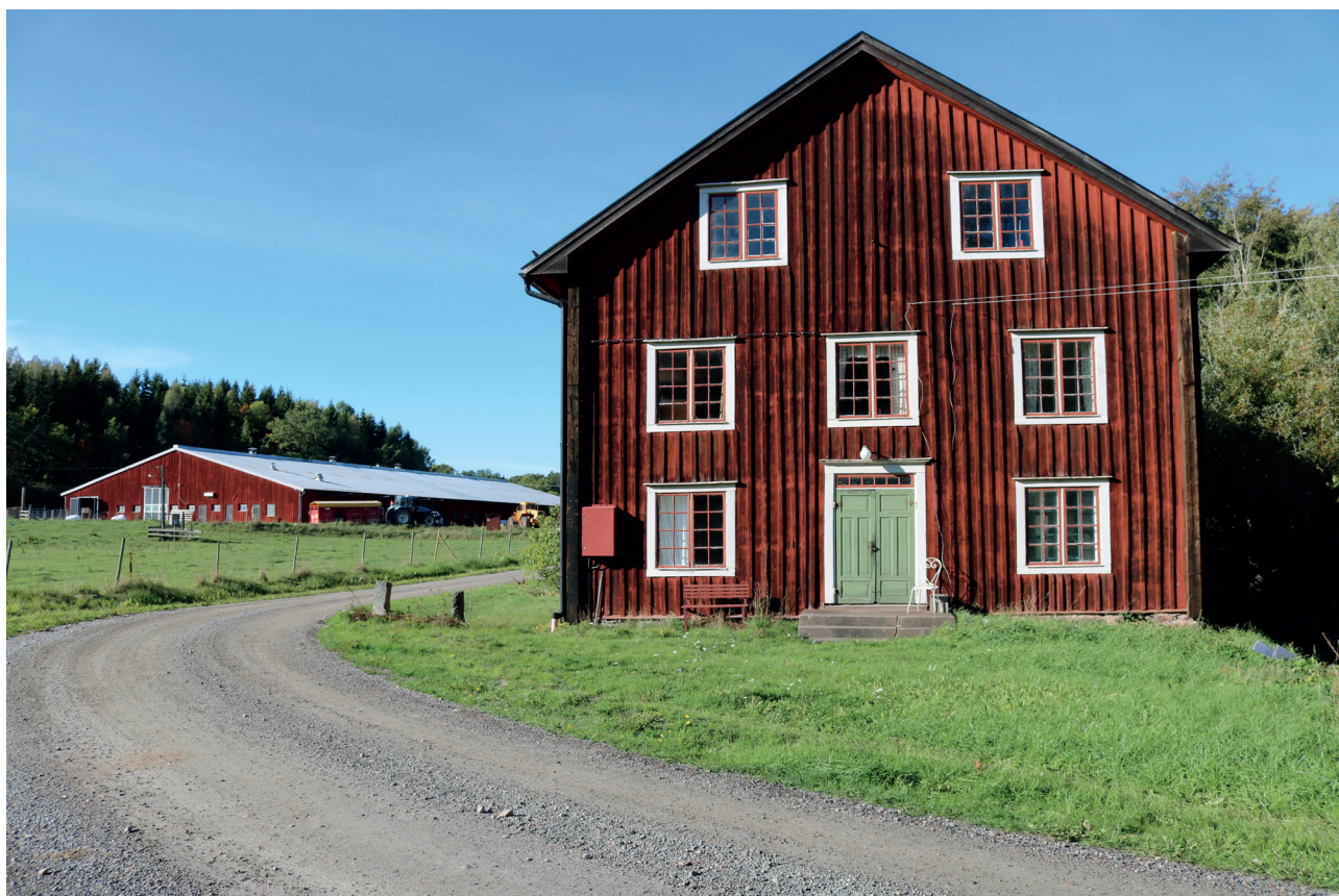
Den välbevarade statarbostaden Mahognyvillan placerad i anslutning till jordbrukets ekonomibyggnader vid Östanå.
