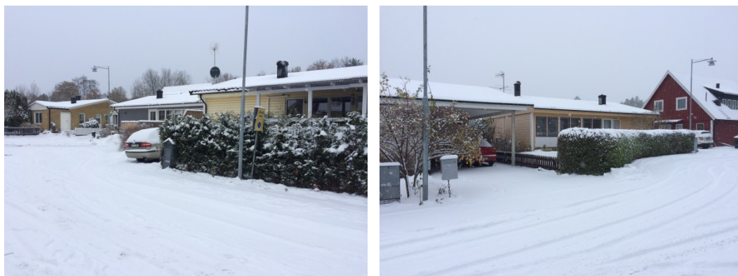
Bild 6. Befintliga byggnader inom planområdet.
