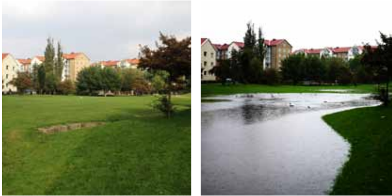
Genom modulering av terrängen inom parkmark kan dessa ytor utnyttjas för flödesutjämning vid kraftig nederbörd och översvämningar inom stadsdelen kan undvikas. På bilden: bräddningsytor i Augustenborg Malmö vid torr väder samt efter stor nederbörd. (Bild t.h.: Miljöförvaltningen Malmö Stad.
