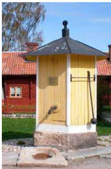
Torg 3 har brunnshus för handdriven vattenpump.
