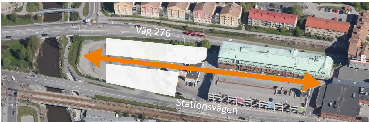
Stråk 5, mellan Åkersbergas inomhuscentrum och kanalen.
