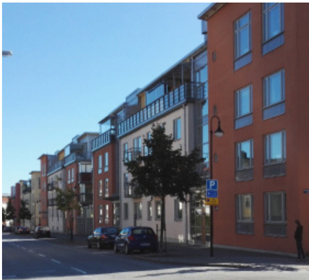
Exempel på varierade fasader, lämplig skala, indragna takvåningar och tydliga entréer i Norrtälje.
