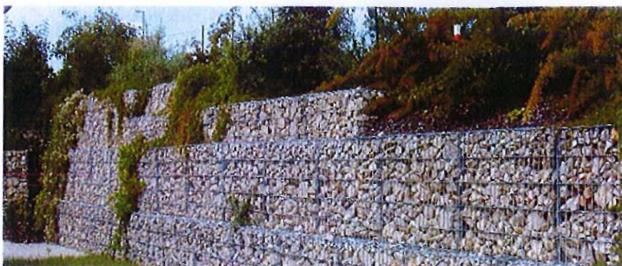
Referensbild från gestaltungsprogrammet som visar stödmur i form av s.k. gabioner.
