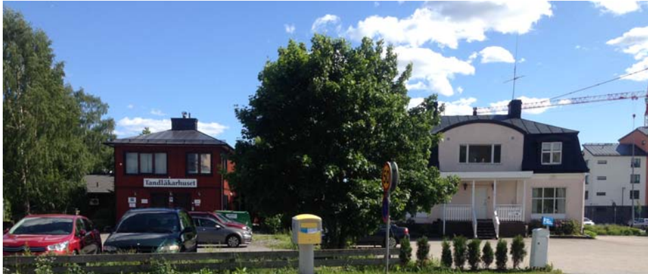
Bild 1. Fastigheten från norr. Tuna 3:58 ligger till vänster om träden. Till höger ligger grannfastigheten Tuna 3:57.
