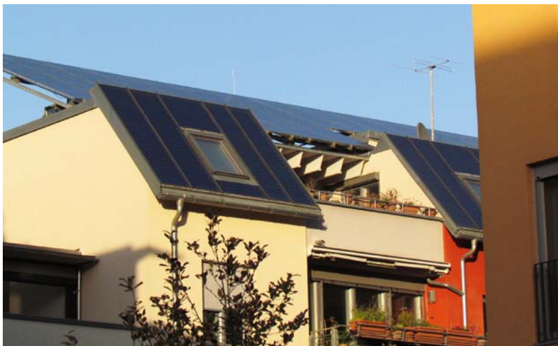
Att investera i solenergi är ett sätt att producera miljövänlig el till hushållen och samtidigt minska sina elkostnader.
