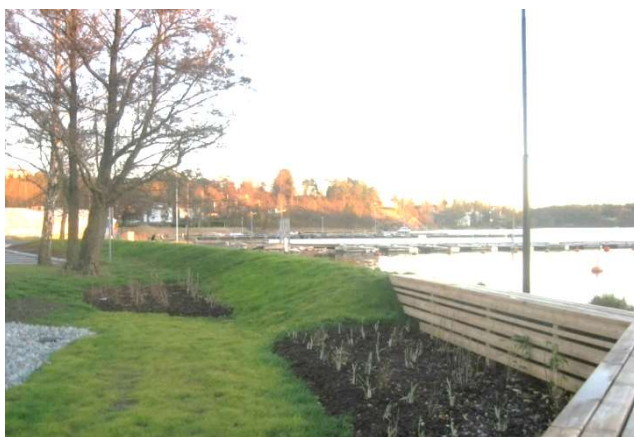
Figur 4 Vall som teknisk skyddsåtgärd (Foto: Danderyds kommun)
