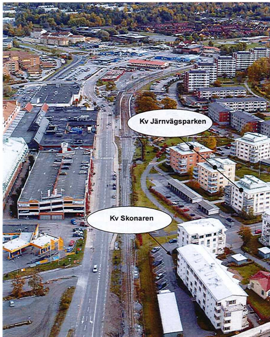
Figur 6. Översikt över Roslagsbanan och kvarteret Skonaren och Kvarteret Järnvägsparken. Observera att bilden är tagen innan dubbelspårutbyggnaden genomfördes.
