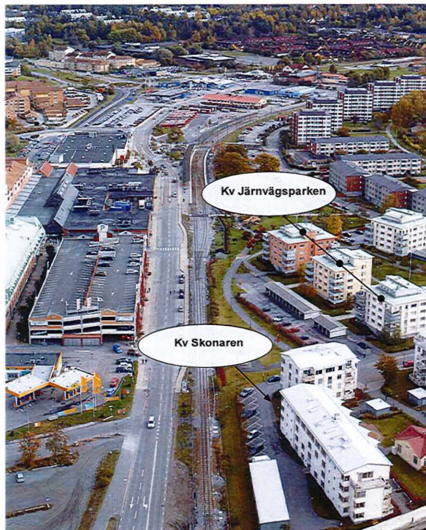
Figur 6. Översikt över Roslagsbanan och kvarteret Skonaren och Kvarteret Järnvägsparken. Observera att bilden är tagen innan dubbelpårsutbyggnaden genomfördes.
