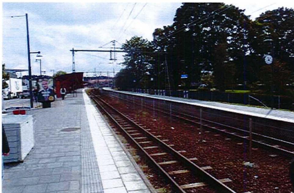
Figur 24. Stationen med Järnvägsparken i bakgrunden.
