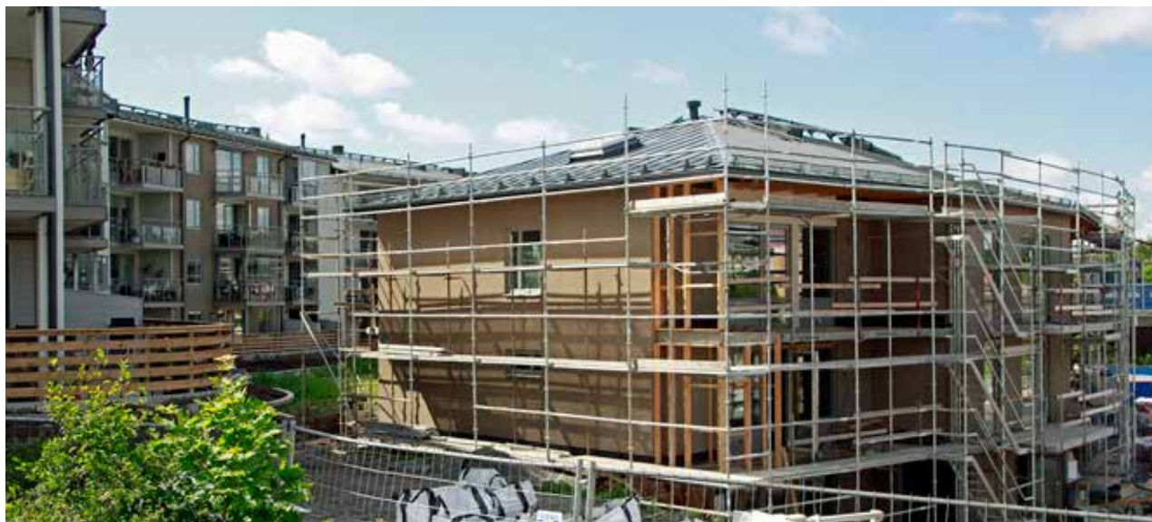
Byggnation vid Bergavägen i Åkersberga.
