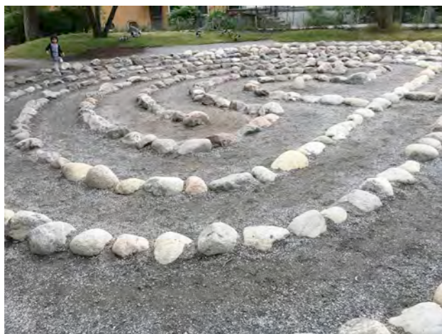
Materialavskiljare i kullersten som bildar en labyrinth i gången med inslag av skiffer
