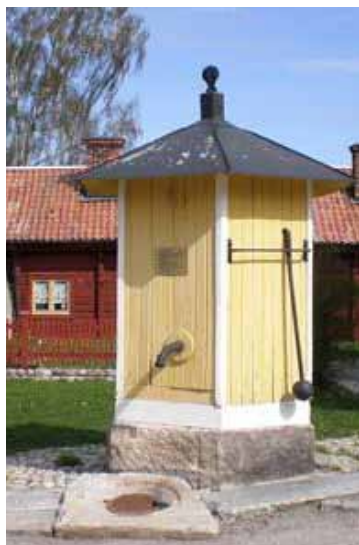
Torg 3 har brunnshus för handdriven vattenpump.
