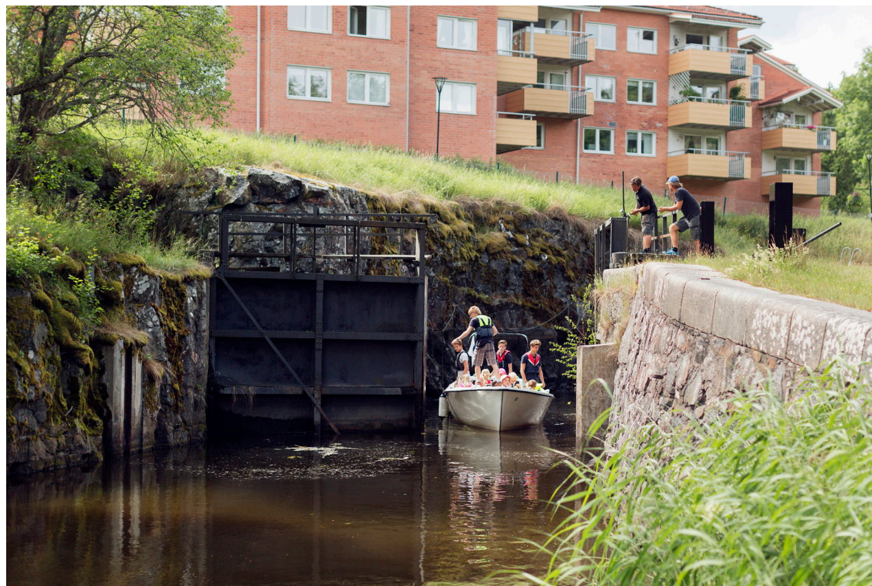
Slussen i Åkers kanal.
