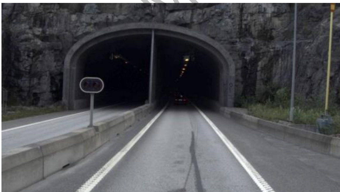
Figur 45 visar ett exempel på tunnel (Löttingetunneln) som upplevs som trång, mörk och ogästvänlig. Källa: Trafikverket (PMSV3).
