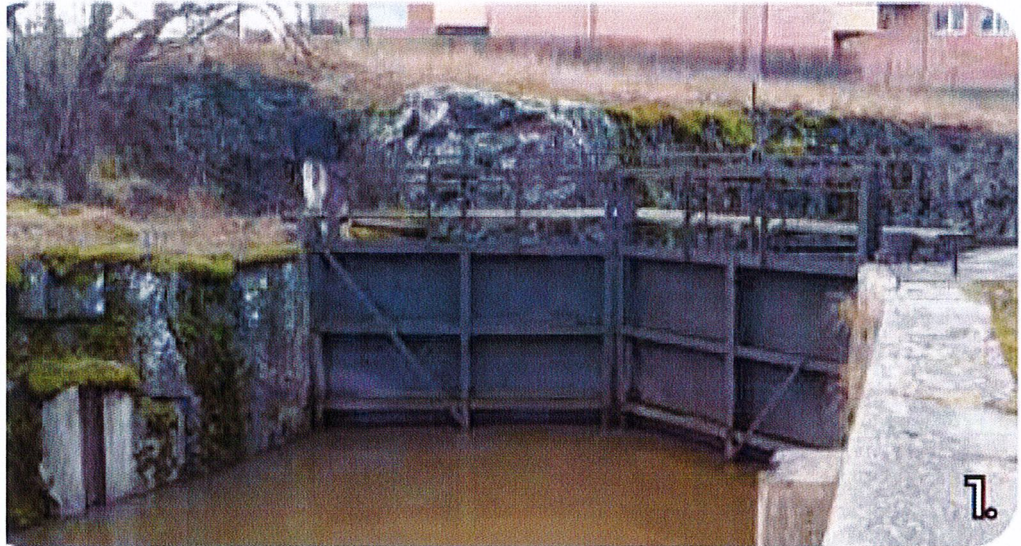
Figur 6. Slussanläggningen (Siffr 1 i Figur 5). (Slussholmen Antikvarisk utredning och konsekvensanalys)
