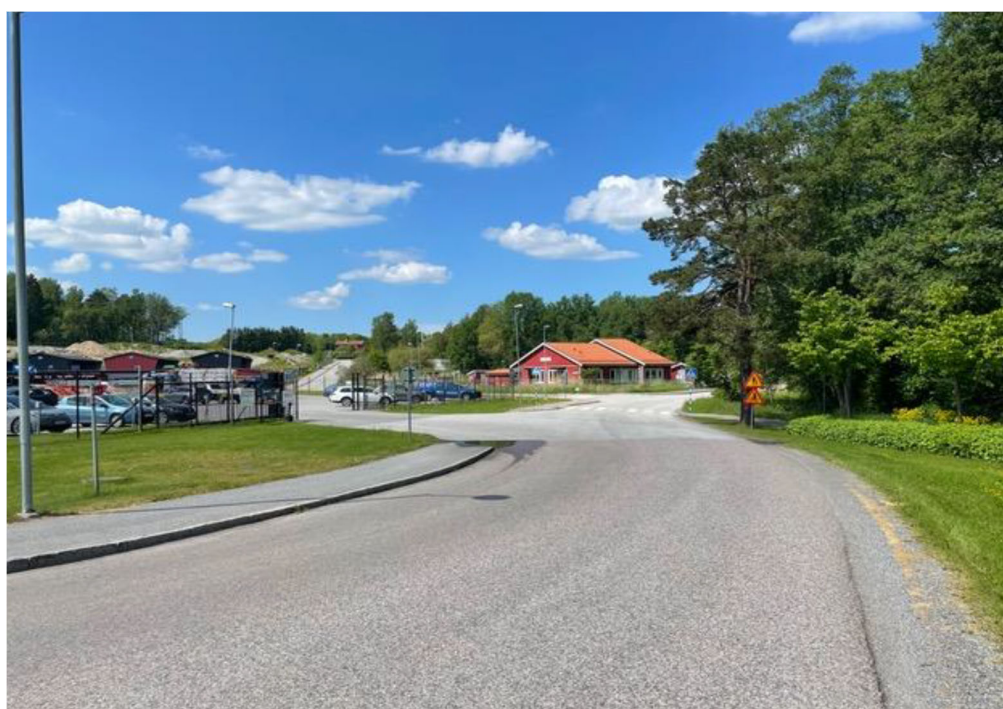
Bilden visar planområdets befintliga förskola sedd från Norrvägen. Gaturummen är öppna och diffusa.
