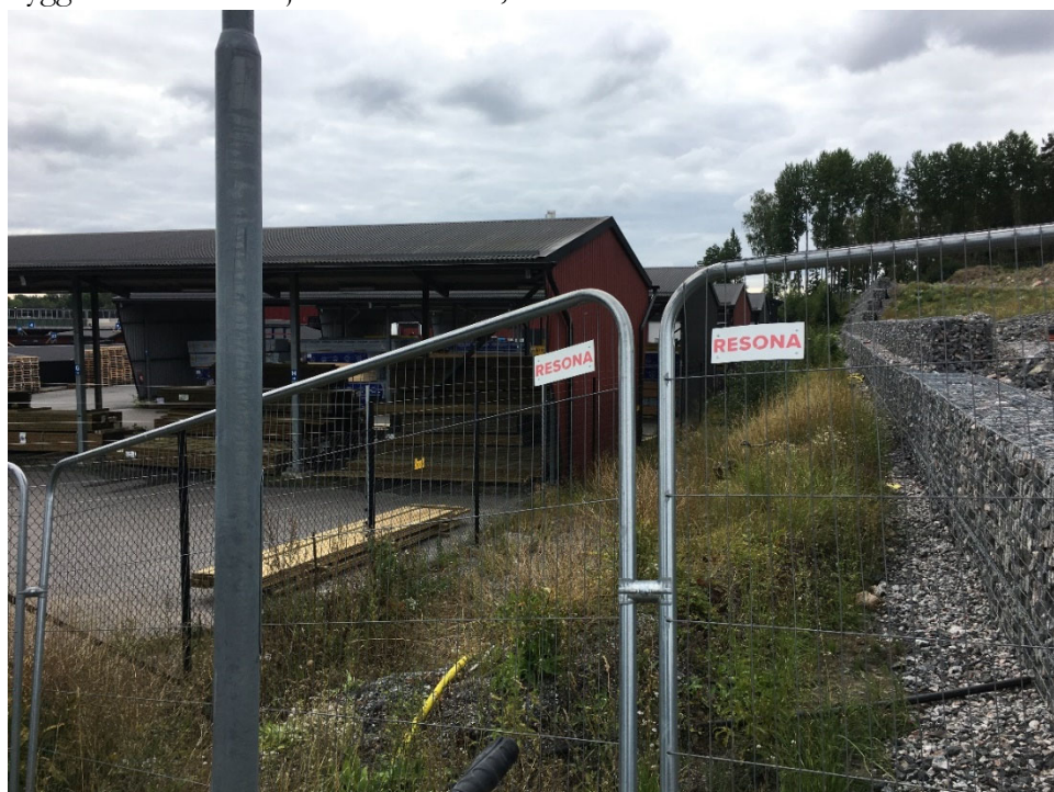
Bilden visar byggvaruhandeln och en del av Säby Hages byggområde.
