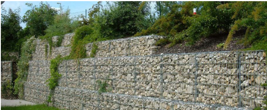
Referensbild från gestaltungsprogrammet som visar stödmur i form av s.k. gabioner.
