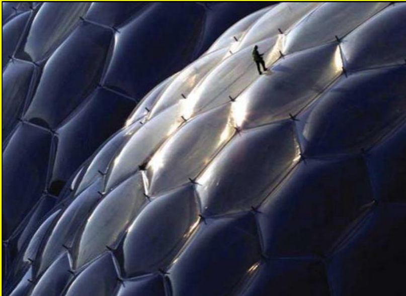
Figur 32. Texlon-kupol. Bilden är hämtad från en broschyr utgiven av Vector-Foltec. Mer info på www.vector-foiltec.com
