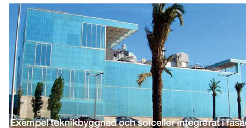
Exempel teknikbyggnad och solceller integrerat i fasad
