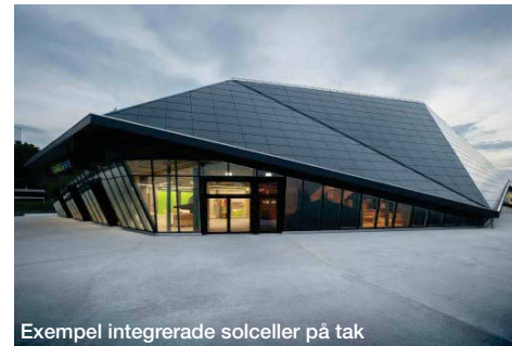
Exempel integrerade solceller på tak
