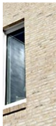
Fönsterbleck i tegel
