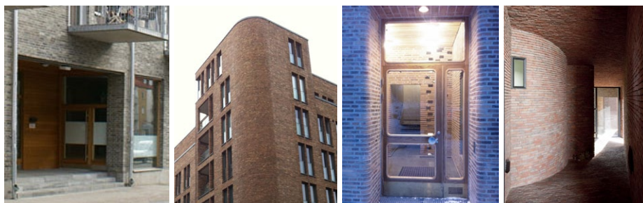
Trä i entré
