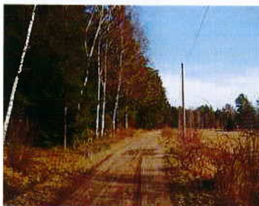
Den befintliga grusvägen genom planområdet
