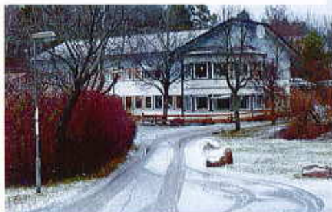
Bild 3. Befintlig kontorsbyggnad sett från väster.
