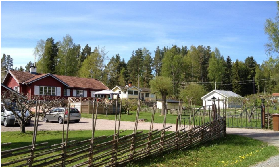
Fastigheter utmed Gränsridarvägen
