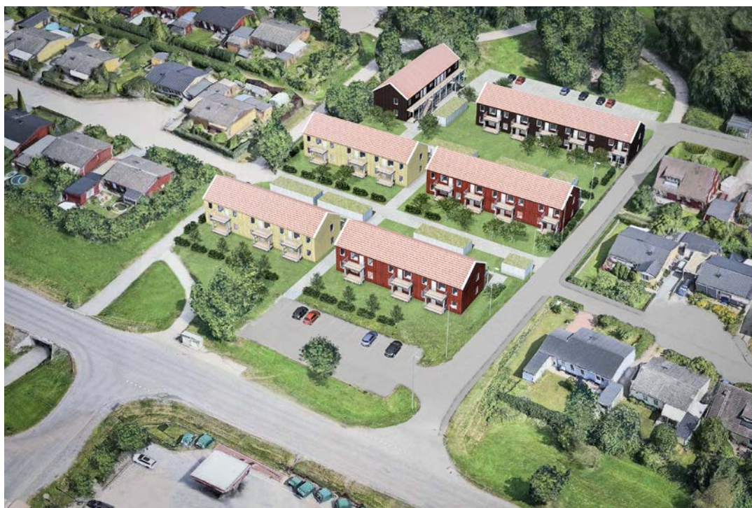
Bild 9. Flygvy över ny bebyggelse, lokalgata och infartsparkering (BoKlok). På bilden saknas vissa åtgärder inom allmän plats.
