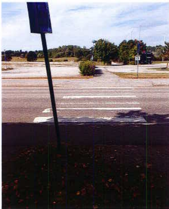
Brist: Oreglerat övergångsställe saknar tillgänglighetsanpassning. Åtgärd: Övergångsstället tillgänglighetsanpassas genom sänkt kantsten för rullstol och kontrastplattor för synsvaga.
