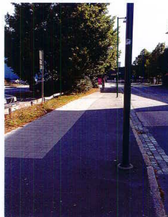
Brist: Stolpar saknar kontrastmarkering. Åtgärd: Kontrastmarkering av stolparna åtgärdas för att underlätta för synsvaga.
