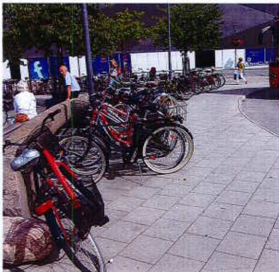
Brist: Bristande ledstråk för synnedsatta på grund av oorganiserad cykelparkering. Åtgärd: Cykeluppställningen byggs in och ledstråk anläggs.
