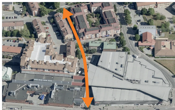
Stråk 4, Stationsvägen - Storängstorget - Bergavägen.
