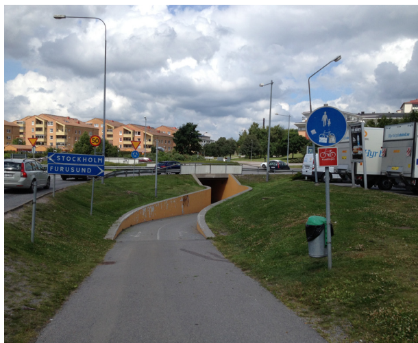
Gång- och cykeltunnel under cirkulationsplatsen vid väg 276.
