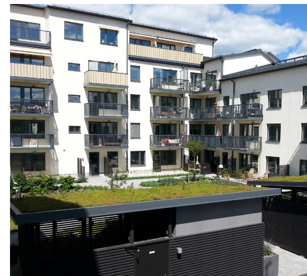
Varierad höjd inom ett bostadskvarter och komplementbyggnader med gröna tak i Östra Kanalstaden.
