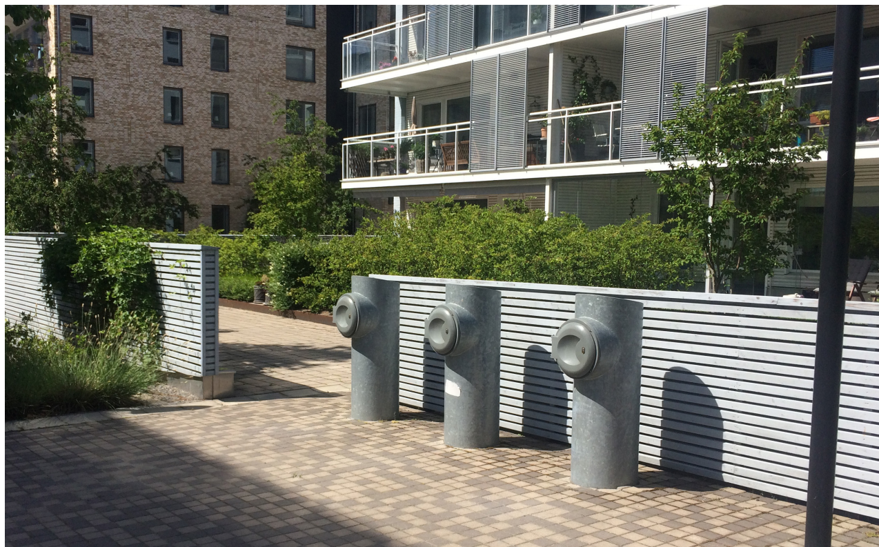
Exempel på sopsugsnedkast på kvartersmark från Dalénum på Lidingö.
