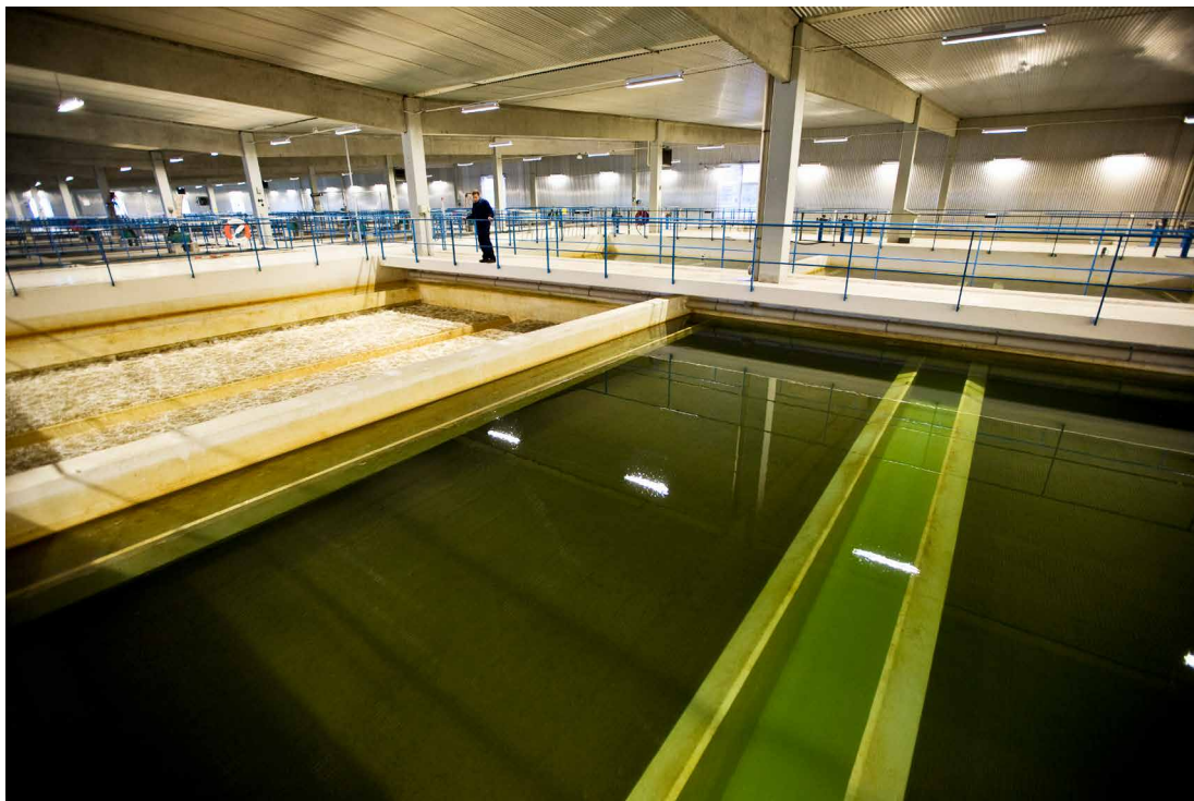
Foto: Kari Kohvakka, Stockholm Vatten och Avfall
