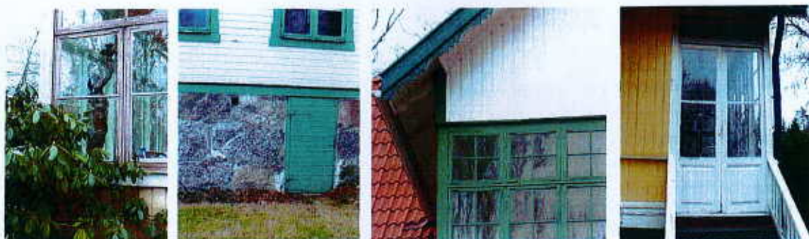
Detaljer som bör renoveras och bevaras eller bytas mot nya som tillverkas efter originalen.
