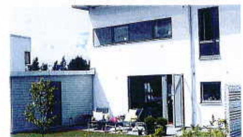
Förråd är rumsbildande på trädgårdssidan, JM, Björkdungen
