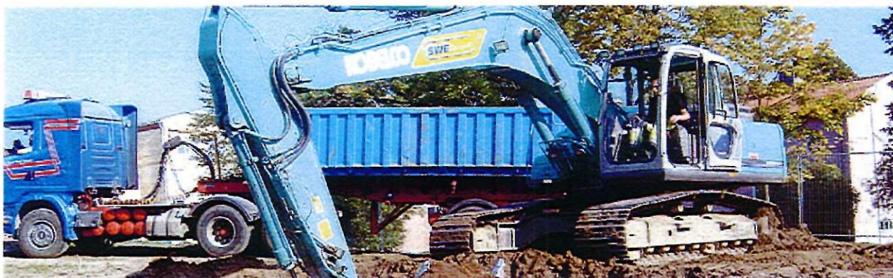
Schaktning för nybygge. Bild: Sweschakt AB.
