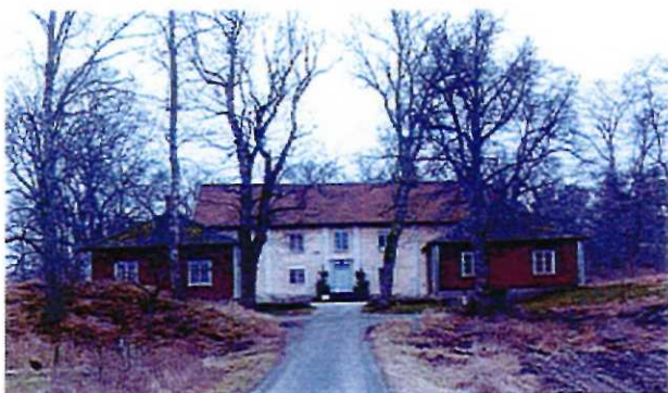
Mälby Herrgård med flygelbyggnader. Bild Nyréns.
