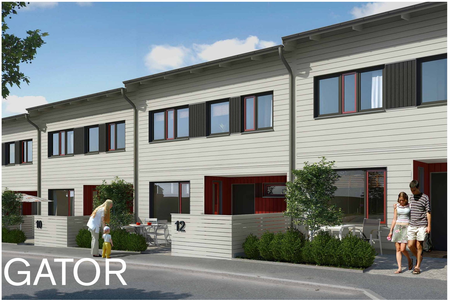
Staket och häckar som avgränsar förgårdsmarken från gatan samspejar med husen. Exempel från JM, Järvastaden.
