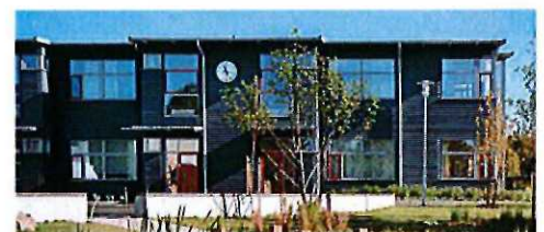
Mörk träpanel står vackert mot grönskan, Presseskolan, Kungsbacka, White.
