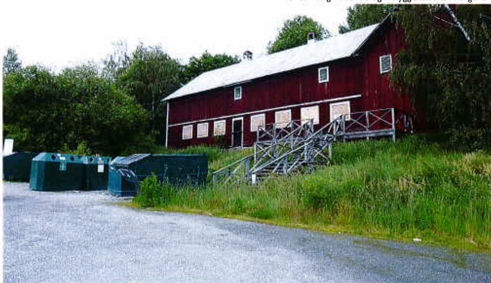
Bild 1. Fastigheten är idag bebyggd med en ladugård.
