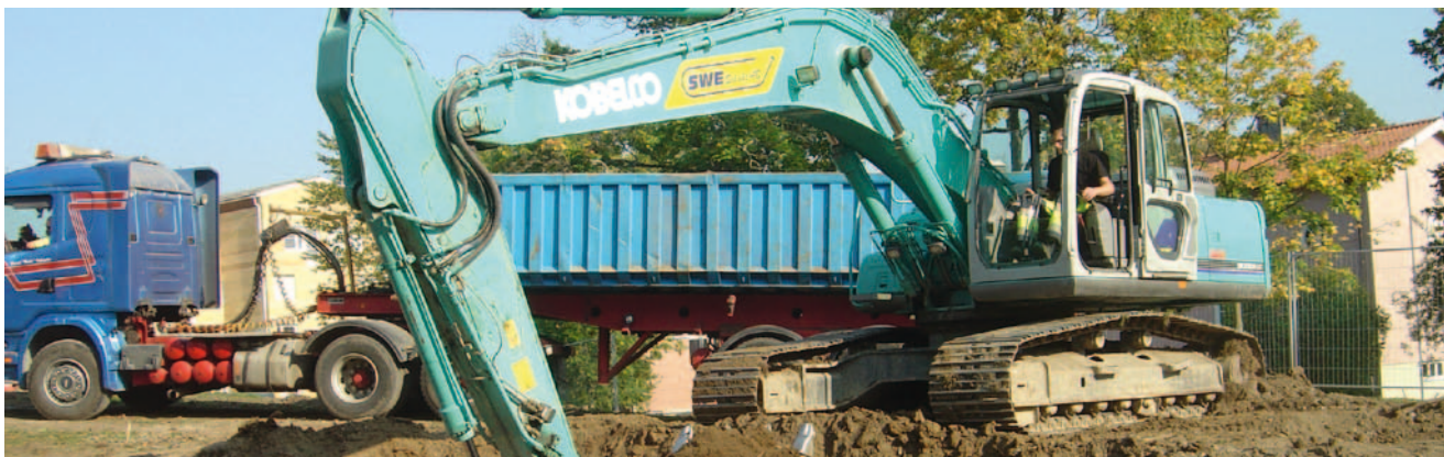
Schaktning för nybygge. Bild: Sweschakt AB.
