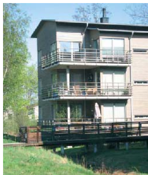
Hammarby sjöstad. Exempel på snedvinklade balkonger som möjliggör bättre utblickar och ger lätthet åt byggnaden. Foto: Joe Lindström
