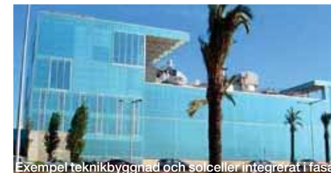
Exempel teknikbyggnad och solceller integrerat i fasad
