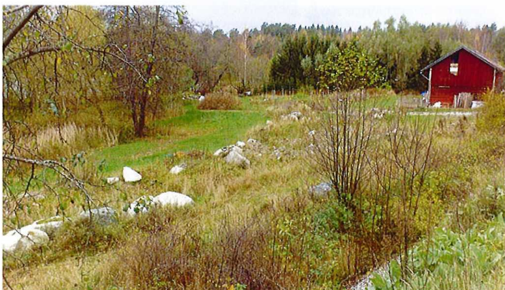
Vypunkt 5. Östra delen av fastigheten är idag anspråktagen där markarbeten för en framtida vattenpark har påbörjats.
