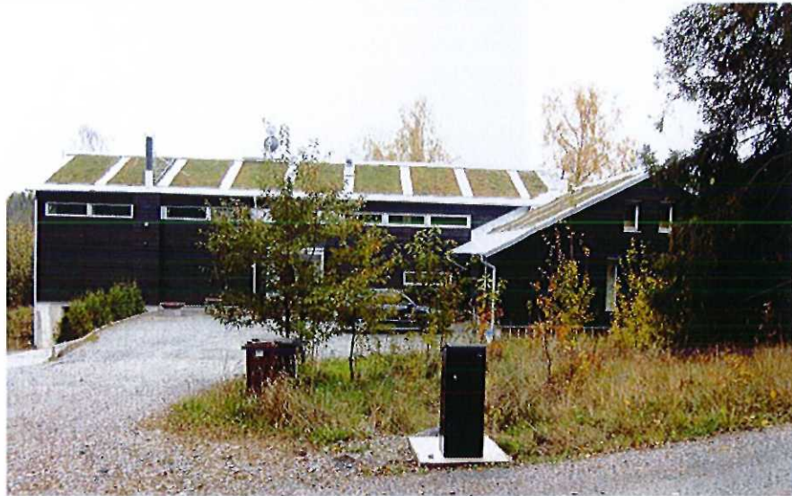
Vypunkt 1. Bostadshuset på fastigheten 2:183 sett från Bodavägen i norr.
