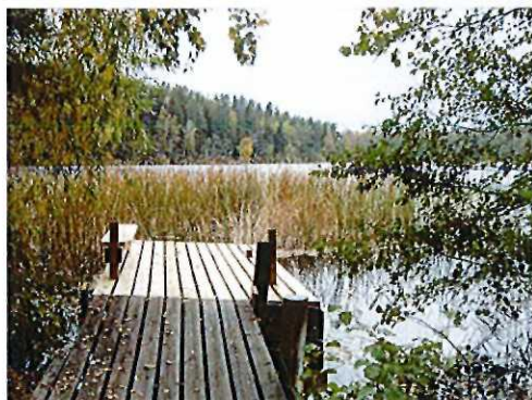
Vypunkt 3. Renoverad brygga vid Boda träsk
